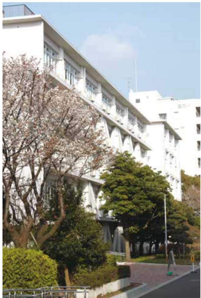
2009年に改修された文学部棟玄関
