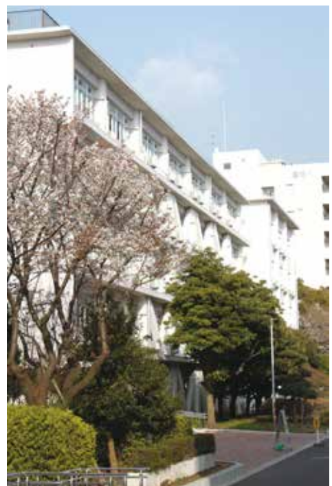
2009年に改修された文学部棟玄関
